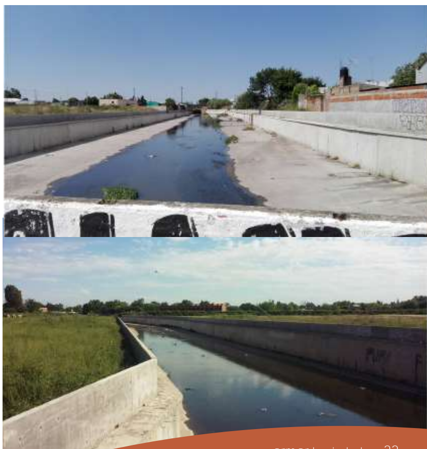
Obras hidráulicas recientes en la cuenca del arroyo del Gato (Gran La Plata).
